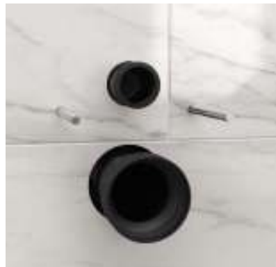
6 Навесьте унитаз на анкера с резьбой. Выровняйте его по уровню. Это может быть сделано с помощью крепежного набора для подвесных унитазов или крепежей для скрытого монтажа, идущих в комплекте с унитазом.
