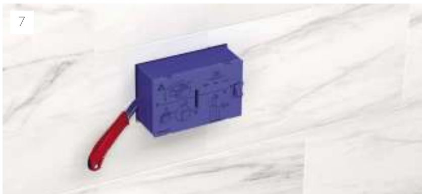
7 Отрежьте короб сервисного окна заподлицо с чистовой стеной.
